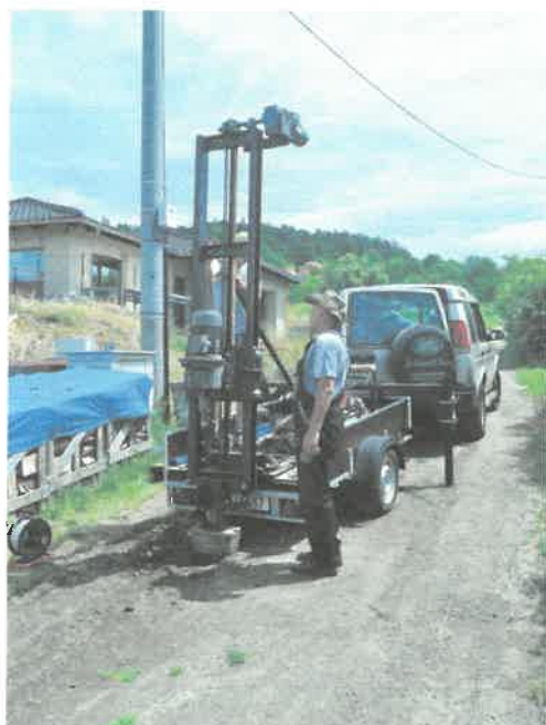
Obrázek 1: Hloubení vrtu IG2
