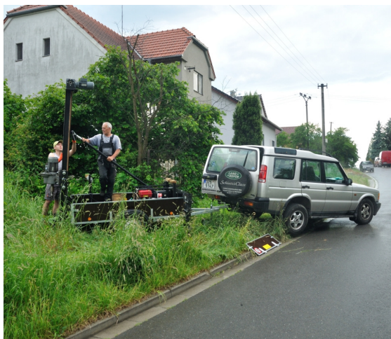
Obrázek 5: Vrtné práce na lokalitě Jungmannova - vrt IG5
